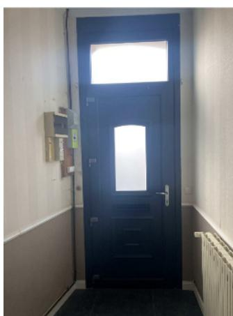
Porte d'entrée PVC isolante récente avec imposte en double vitrage. Etanche à l'air.
