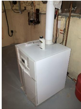
*Chaudière gaz au sol hors volume chauffée. Réseau de distribution non calorifugé.*
