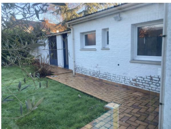
Extension (WC et SdB) et dépendances. Murs en brique de terre cuite et toiture en tuile terre cuite. Traces de remontées capillaires sur les murs. Joints des briques en bon état.
