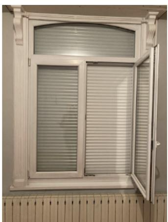
Menuiseries PVC récentes en double vitrage 4/18/4 et volet roulant PVC (côté rue). Coffre de volet roulant ancien en bois non isolés et non étanche à l'air.
